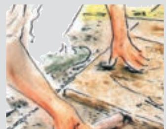
Eine ca. 3 – 6 cm Mörtelschicht aus frostsicherem trasshaltigen Mörtel z. B. *Baumit PflasterDrainmörtel plus GK 4* oder *GK 8\*\** in erdfuchter Konsistenz herstellen.
