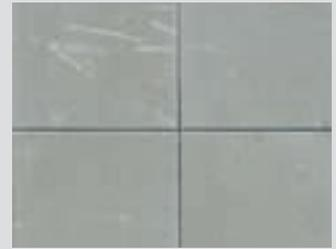
Transportbedingte Scheuerspuren werden durch natürliche Bewitterung neutralisiert.
