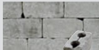
Verlegen Sie auch Steine mit stärker oder unregelmäßig gealterten Kanten und Ecken. Dieses antike Aussehen ist erwünscht und macht bei richtiger Verlegung und Verfugung den Reiz der antiken Fläche oder Mauer aus.
