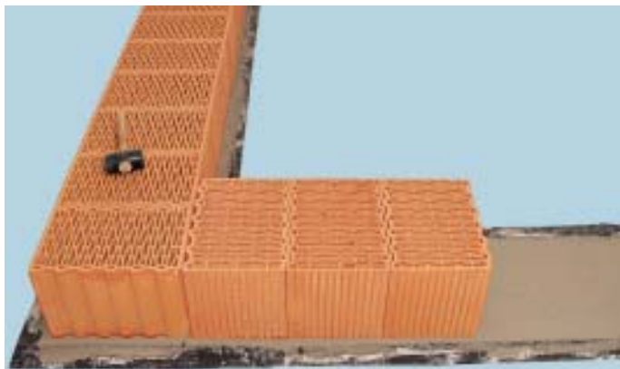
Položenie prvého radu tehál do zakladacieho maltového lôžka
