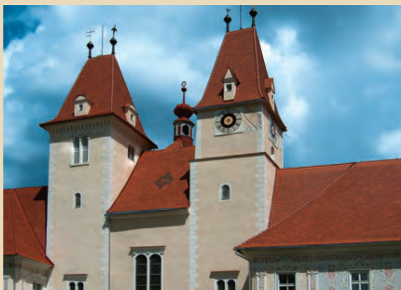
Sanácia historickej strechy - Viedenská škridla staromestská.
